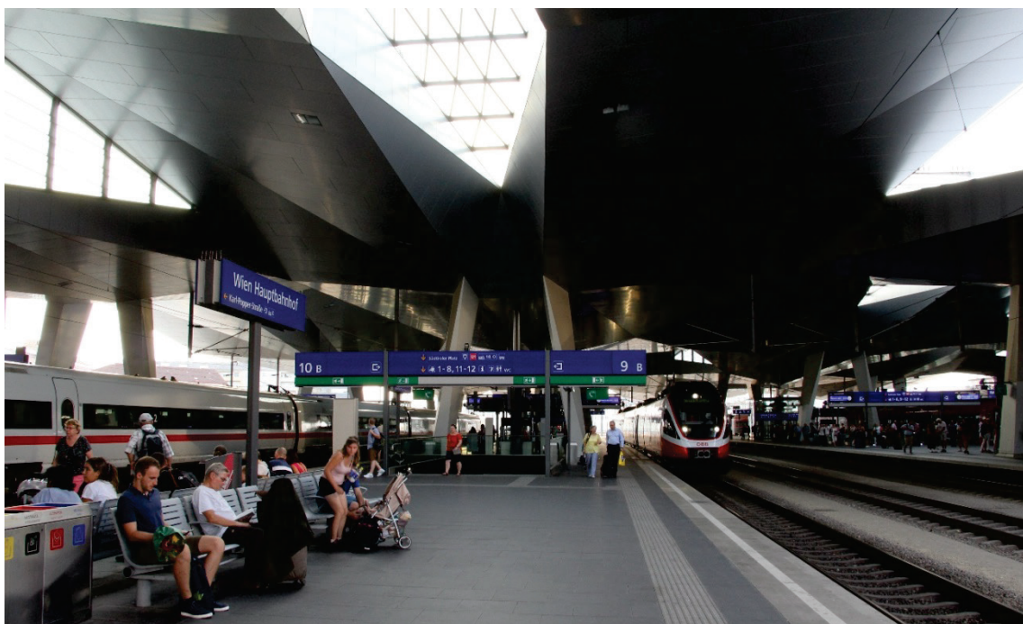
2.1., 2.2. ábra. Wien Hauptbahnhof, forrás: Döbrentei Balázs
